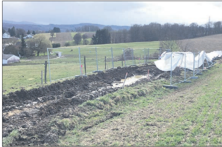
Die Giftmüll-Sanierung beim Klepferhof am Dienstag. Der Ort liegt rund 300 Meter von der Schönenbucher Grenze weg.
