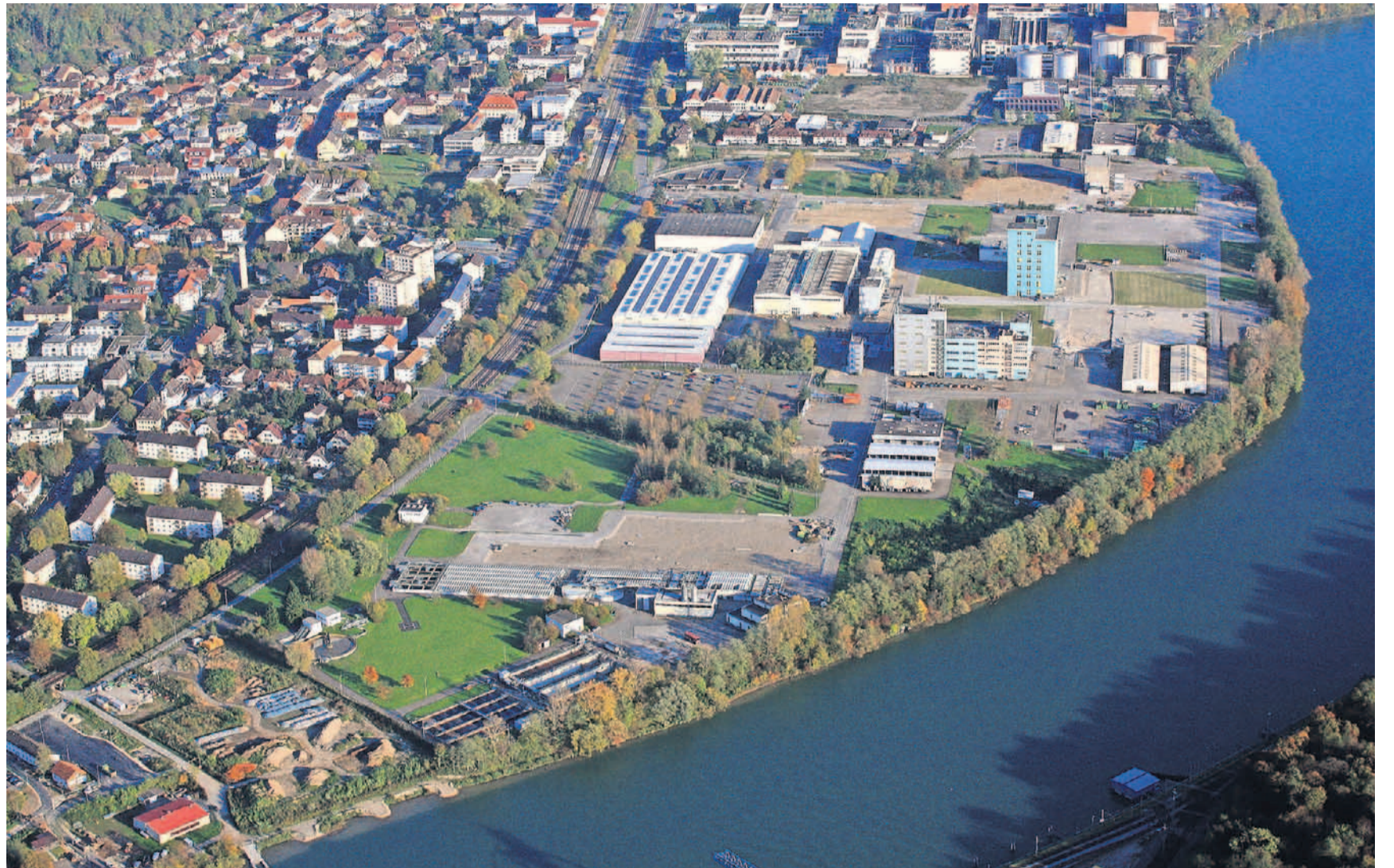
Im Vordergrund links unten auf dem Roche-Perimeter wird bereits der Aushub vorbereitet. Die Sanierung auf dem BASF-Perimeter bleibt umstritten.
